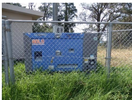
永吉 5 号井戸 発電機設置
