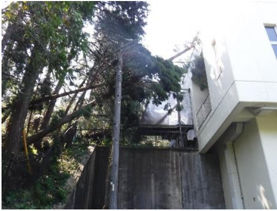
第2中継ポンプ場 受電箇所への倒木
