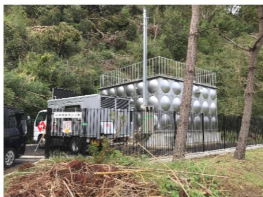
電源車による電力供給状況 (志駒増圧ポンプ場)
