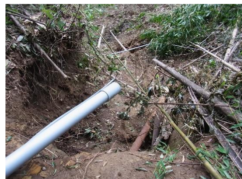
土壌の流失による地下埋設物の露出状況 （丹原送水場送水管路）
